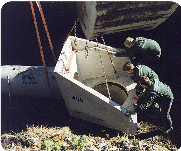
Montering av bekkeinntak med sandfang
