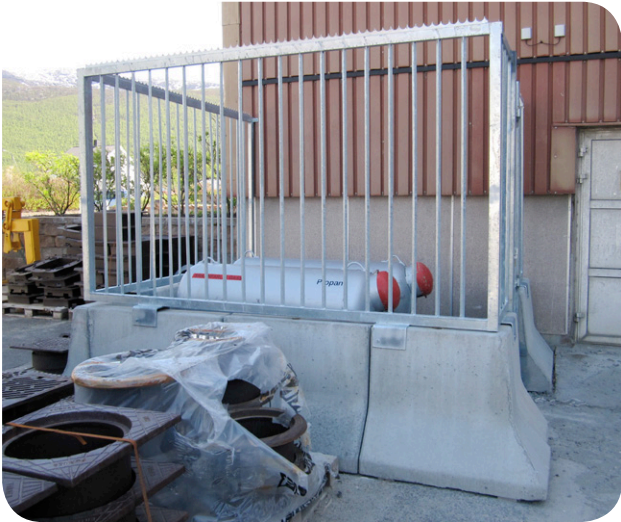
Avsperring propantanker ved fabrikkianlegg.
